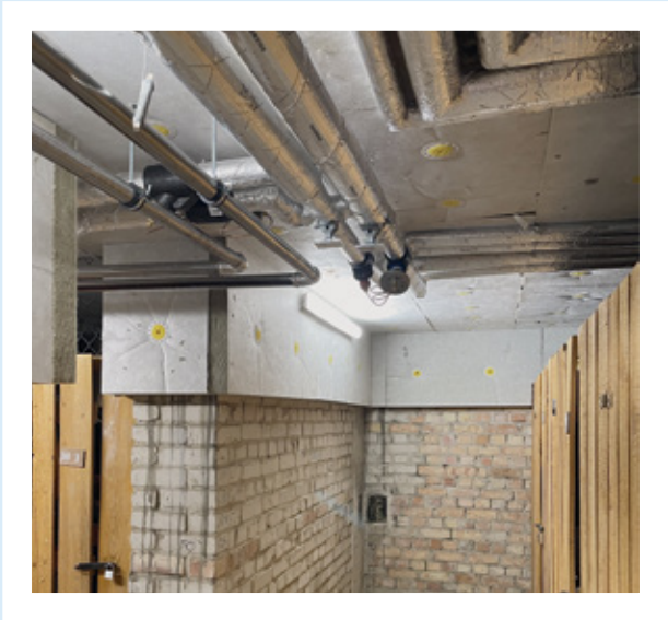
Kellerdeckendämmung Harzer Str. 38
