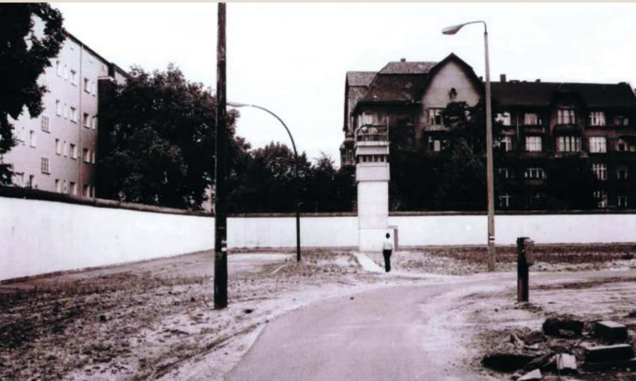
Blick vom ehemaligen Grenzgebiet der DDR auf die Harzer Straße 15 und 16 in Berlin – Neukölln. Links das Haus Bouchéstraße 57.
