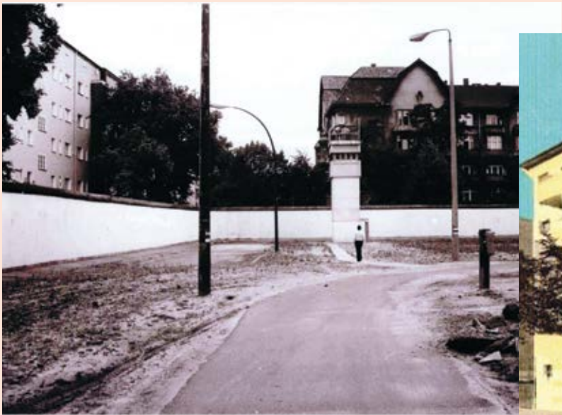
Blick vom ehemaligen Grenzgebiet der DDR auf die Harzer Straße 15 und 16 in Berlin – Neukölln. Links das Haus Bouchéstraße 57.
