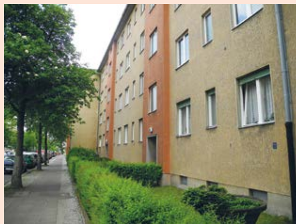
Bürgerstraße 63 – 77, Berlin – Britz, vor der Modernisierung
