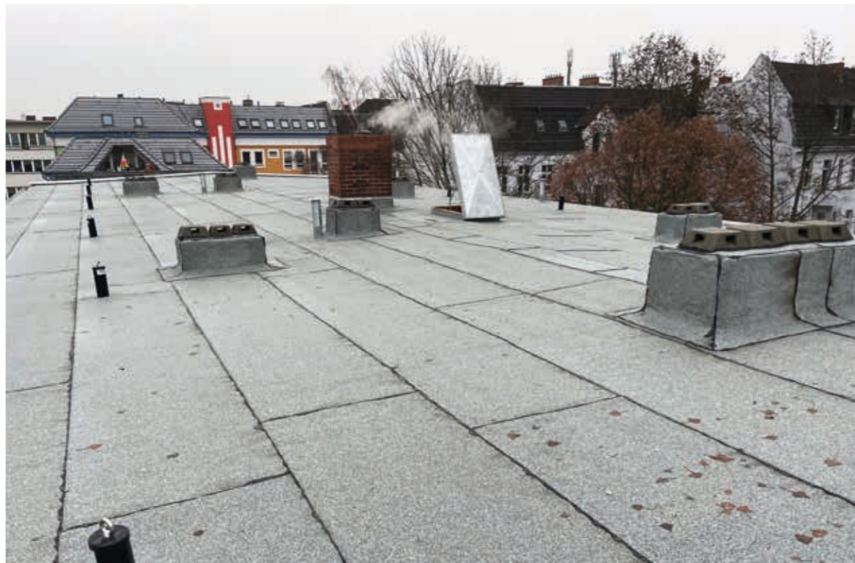
Neues Dach, Baublock 12, Waldstr. 47/48, Berlin-Reinickendorf
